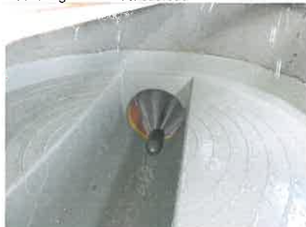
Abbildung 4: Düse im Einsatz
